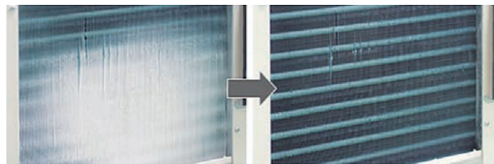
冷却器に霜が発生するとセンサーが動き、自動霜取機能が作動
